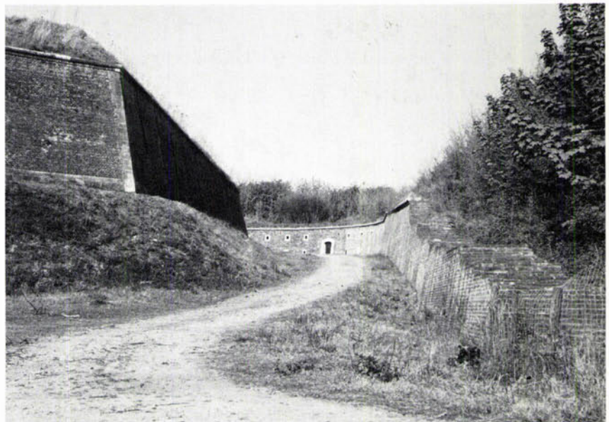
Figuur 1. Blick in één van de droge grachten tussen de met muren versterkte aarden wallen. (Foto: M. Pekelharing, 1988).
